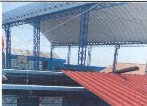
Foto1: Sustitución de lamina calibre 26.
