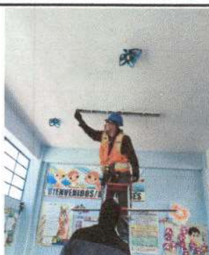
Foto 3: Reparación de cableado electrico.
