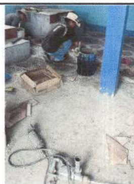
Foto 4: Sustitución de piso de cemento.
