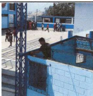
Foto 3: Sustitución de estructura de techo.
