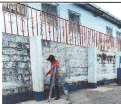
Foto 5: Pintura en muro.
