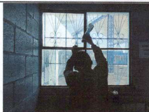
Foto 2: Sustitución de vidrio.
