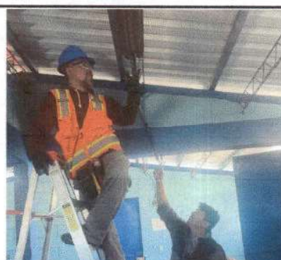
Foto 4: Sustitución de lamparas.
