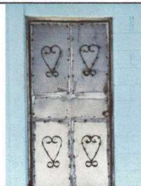
Foto 2: Sustitución de puertas de metal.
