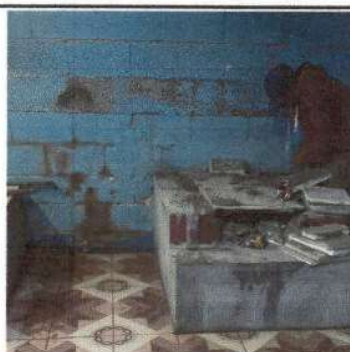
Foto 5: Instalación de azulejo en estufa rural.
